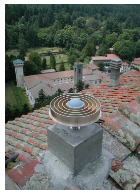
foto 10 – L'antenna installata. Sullo sfondo l'Abbazia di Vallombrosa
