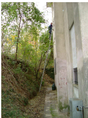
foto 16 – Fase di posa del cavo antenna
