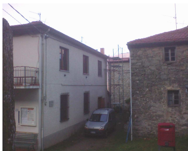
foto 28 – Il pilastro costruito sul muro esterno
