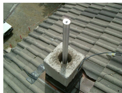
foto 23 – Il sostegno pronto per essere fondato nel cemento
