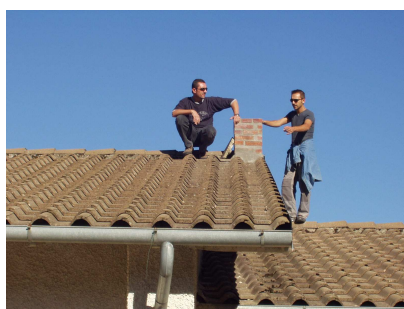
foto 14 – Il pilastro sbagliato
