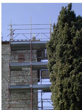
foto 1 – Il pilastro visto dal basso
