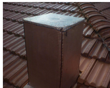
foto 29 – Il pilastro rivestito
